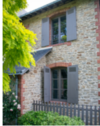
Finition des volets réalisée par le client
